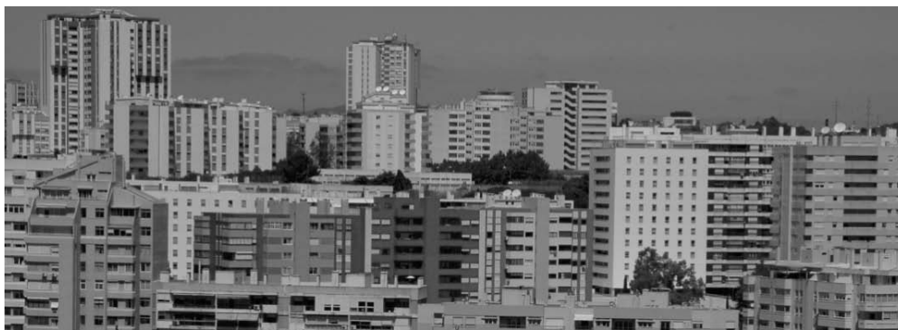
Fotografia 4 — Parque habitacional (DGT, 2013)
