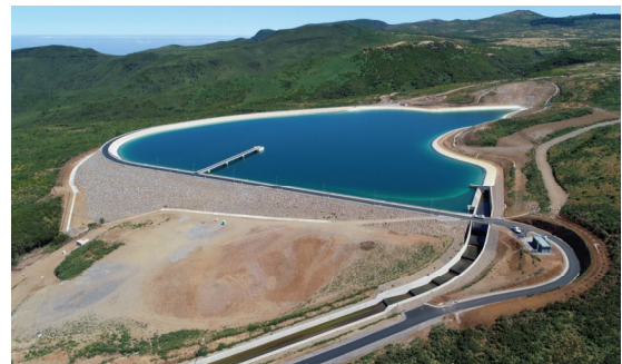
Ampliação do Aproveitamento Hidroelétrico da Calheta Beneficiário: EEM – Empresa de Eletricidade da Madeira, S.A.
