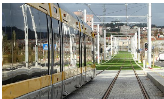
Extensão do Metro do Porto: Linha Amarela (Santo Ovídio - Vila D'Este) Beneficiário: Metro do Porto, S.A.
