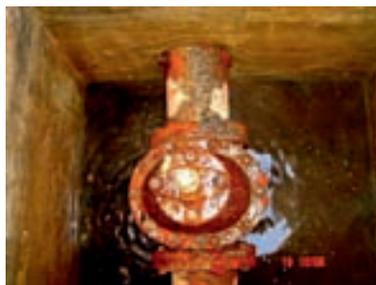
**Figura 9.1 – Inspeção visual na zona circundante à conduta (à esquerda) e a válvula de seccionamento alojadas em caixa (à direita)**
