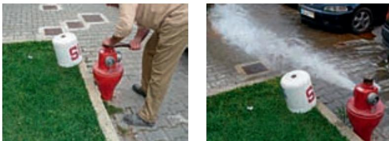
Figura 10.7 – Descarga da conduta através de marco de incêndio
