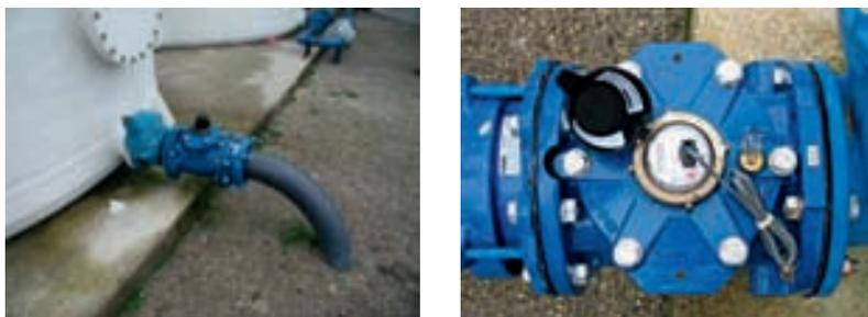
Figura 9.14 – Contador mecânico (também designado por medidor de caudal volumétrico) instalado à saída de reservatório
