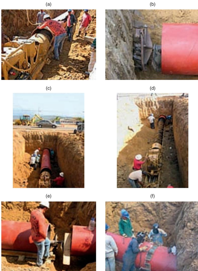
**Figura 10.37 – Instalação de conduta nova com perfuração com trado:**
