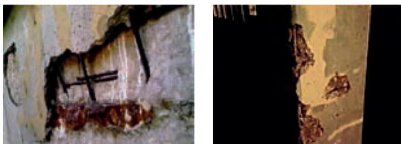
**Figura 10.39 – Estrutura de um reservatório com armaduras à vista (antes da reparação)**
