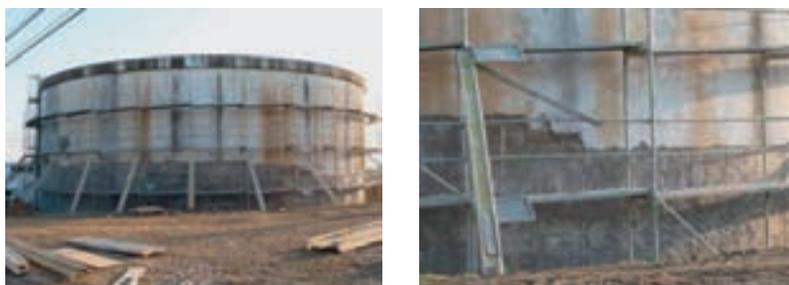
**Figura 10.40 – Remoção do revestimento exterior e impermeabilização de reservatório (durante trabalhos de reparação)**
