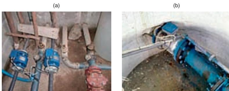
**Figura 9.16 – Caudalímetros electromagnéticos instalados (a) à saída de reservatório e (b) à entrada de ZMC**
