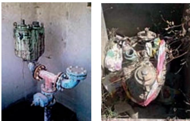
**Figura 2.25 – Deficiente manutenção de ventosas**
