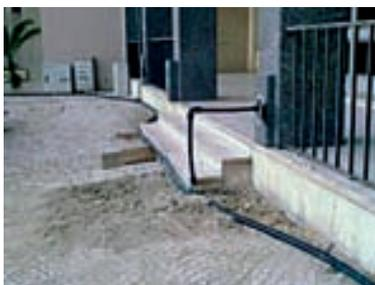
**Figura 10.2 – Execução de ramais provisórios durante a intervenção**
