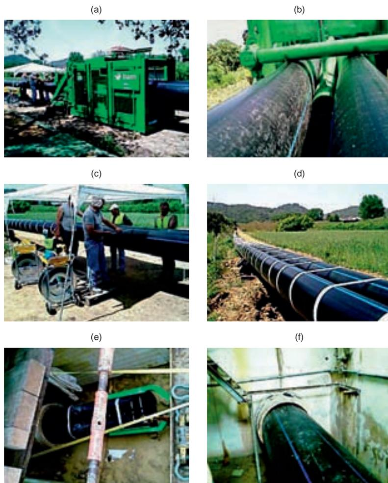
**Figura 10.14 – Entubamento com tubagem dobrada:**
