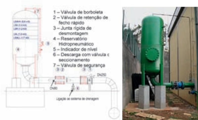
Figura 2.15 – Reservatório hidropneumático “tipo” utilizado para protecção contra choque hidráulico em condutas elevatórias
