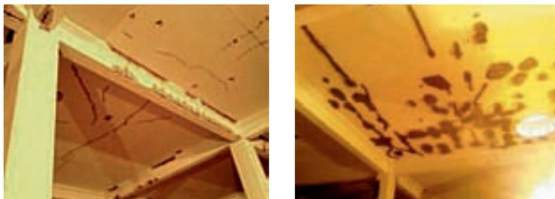
**Figura 10.38 – Fissuras na cobertura de um reservatório: antes e após a reparação com argamassa**
