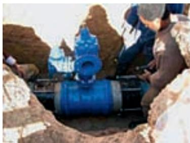
Figura 10.4 – Instalação de válvulas e acessórios após a intervenção
