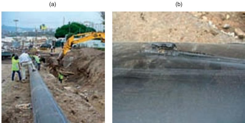
**Figura 2.19 – (a) Instalação de condutas de polietileno: (b) Conduto com rasgo longitudinal decorrente dos trabalhos de montagem**
