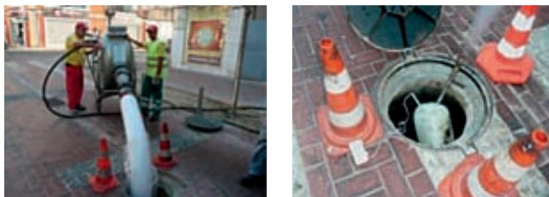
**Figura 10.17 – Entubamento com tubagem curada *in situ* (inserção por inversão)**
