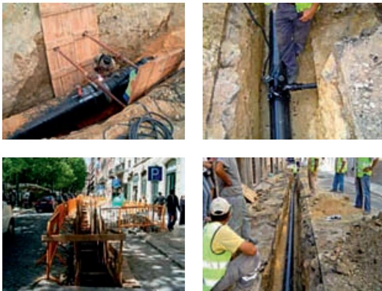
**Figura 10.21 – Substituição com vala aberta (método convencional)**
