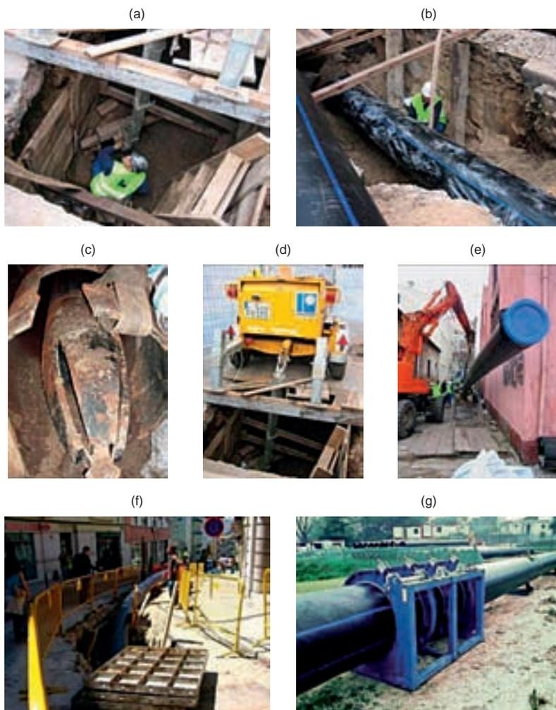
**Figura 10.11 – Entubamento com tubagem contínua:**
