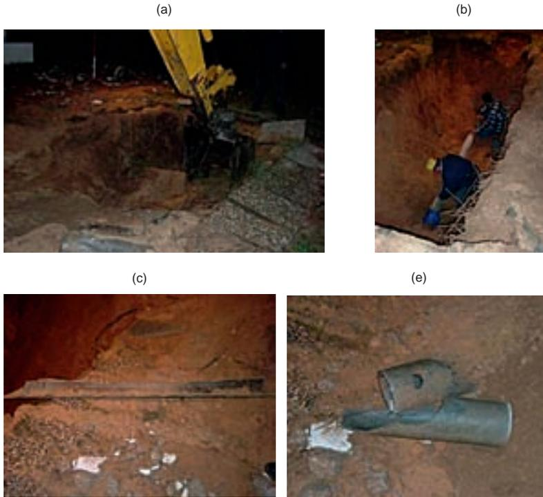
**Figura 2.20 – Rotura em conduta: (a) abatimento do pavimento; (b) conduta após reparação; (c) fragmento de conduta; (d) orifício provocado por uma pedra**
