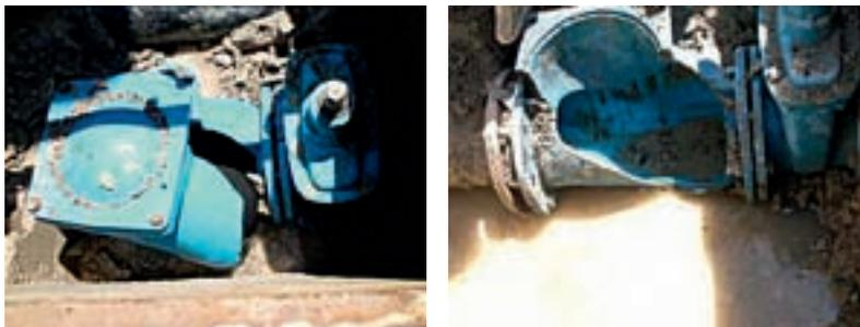
Figura 2.23 – Rotura numa válvula de retenção
