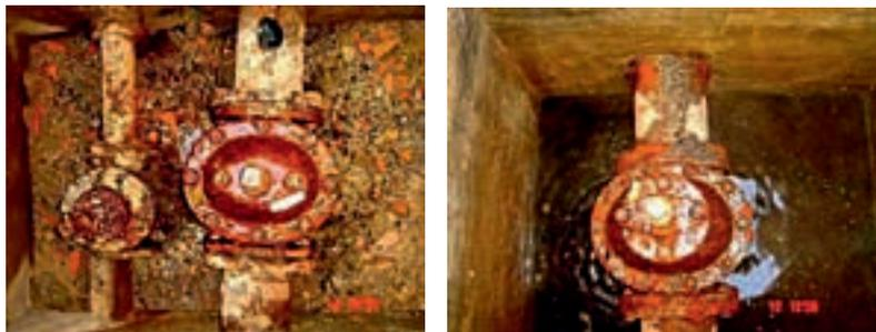
**Figura 2.24 – Fugas em juntas de ligação de válvulas de descarga decorrentes da deficiente manutenção do equipamento**
