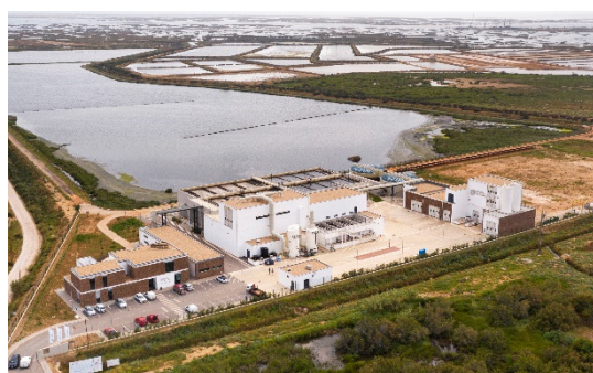
ETAR de Faro/Olhão e Sistema Elevatório de Olhão Beneficiário: Águas do Algarve, S.A.
